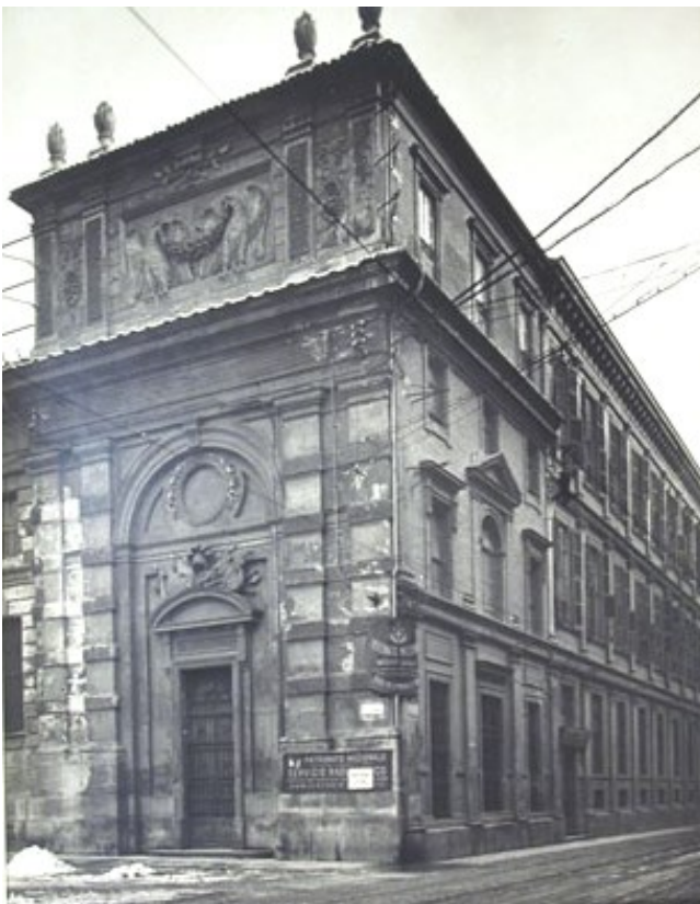
Fig. 8. Palazzo Debito Pubblico, ingresso su piazza Carlo Alberto angolo via Principe Amedeo, in Franca Porticelli, Torino 1904. Dopo l'incendio: 1. Gli interventi nell'emergenza e i primi restauri; 2. La decisione di costruire una nuova sede: un'indagine nei documenti d'archivio, Scrineum Rivista, vol. 17, 2020. https://go.gale.com/ps/i.do?p=AONE&u=googlescholar&id=GALE|A647748412&v=2.1&it=r&sid=googleScholar&asid=2d6e4e0a
